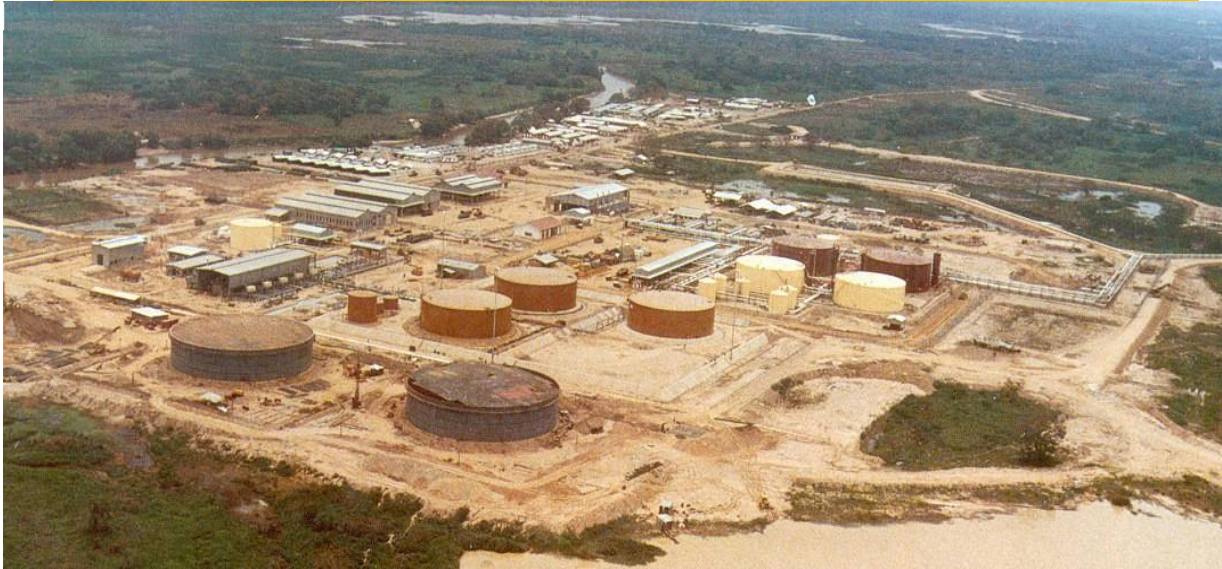
Construcción de Tanques de Almacenamiento
